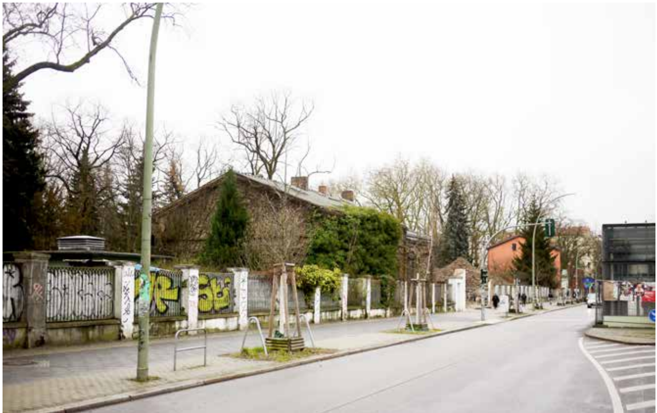
Bestandsgebäude an der Hermannstraße mit straßenbegleitenden Zaun, rechts Aufzug zum U-Bahnhof Leinestraße
